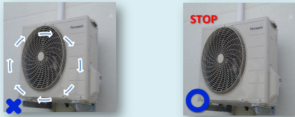
強風によりエアコン室外機の羽(プロペラ)が逆方向に回転し故障します。
